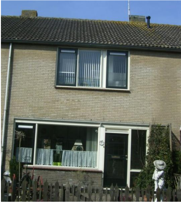
Voorgevel met vernieuwd kozijn oude situatie
